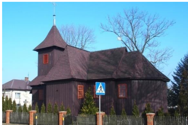
Zdjęcie nr 9. Kościół pw. św. Leonarda i Wniebowzięcia NMP, ul. Sienkiewicza
