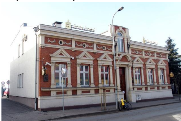
Zdjęcie nr 18. Budynek mieszkalny, ul. Poznańska 15
