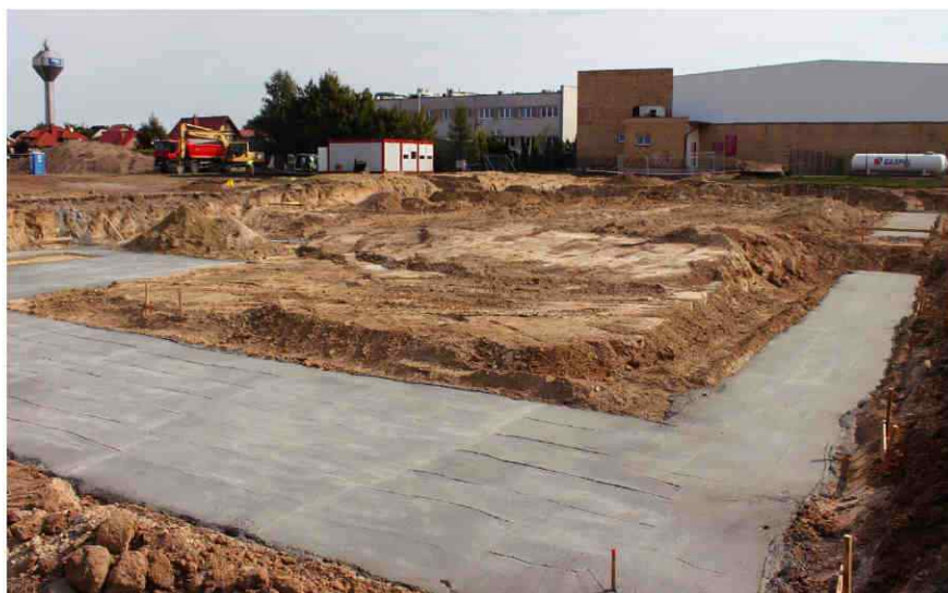
W dniach 10-11 września wylane zostały tak zwane betony podkładowe
