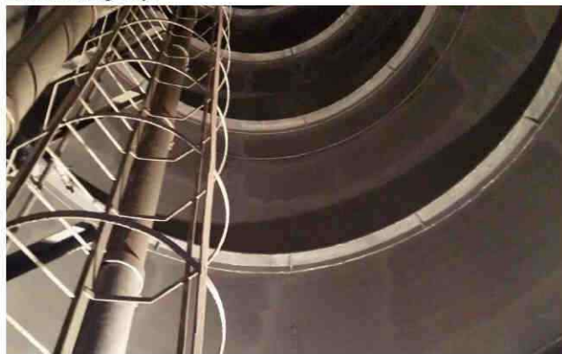
Wnętrze wieży po zakończeniu remontu
