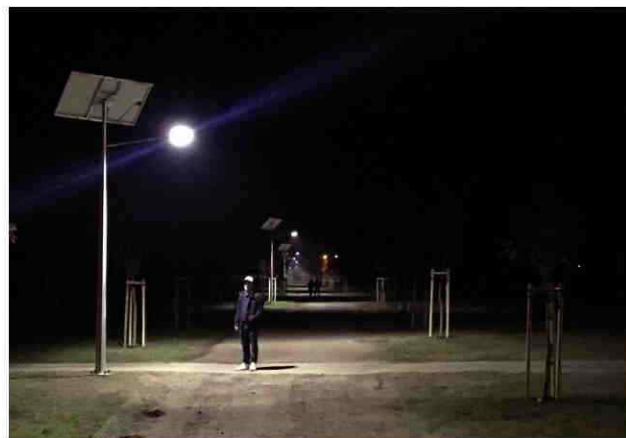
Promenadę oświetlają latarnie zasilane bateriami solarnymi
