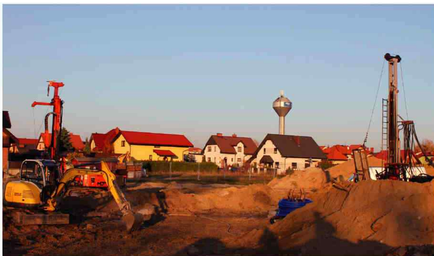
Na zdjęciu widać konstrukcje wiertnicze, wykonujące odwierty ujęć termicznych
