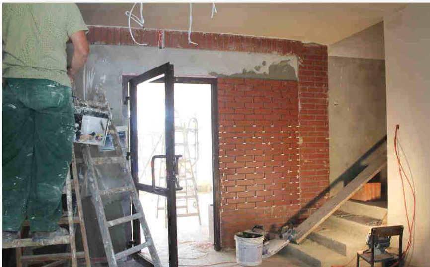
Trwa remont klatki schodowej w Przedszkolu nr 2 „Miś”
