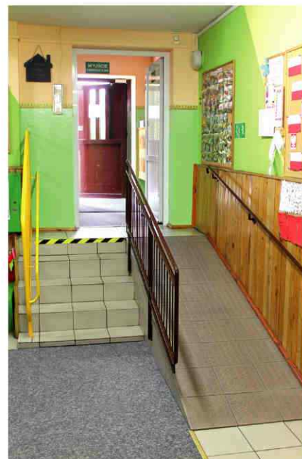
Podjazd dla niepełnosprawnych
