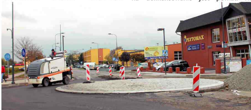
Rondo przy ul. Kopernika i Sikorskiego usprawni ruch pojazdów
