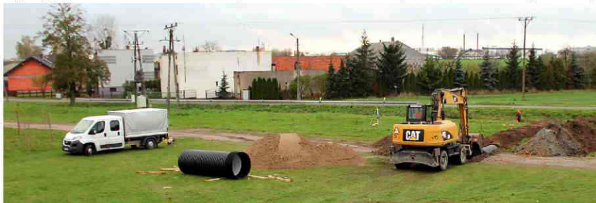
Ruszyły już prace przy sieci kanalizacyjnej w przedłużeniu ul. Batorego
