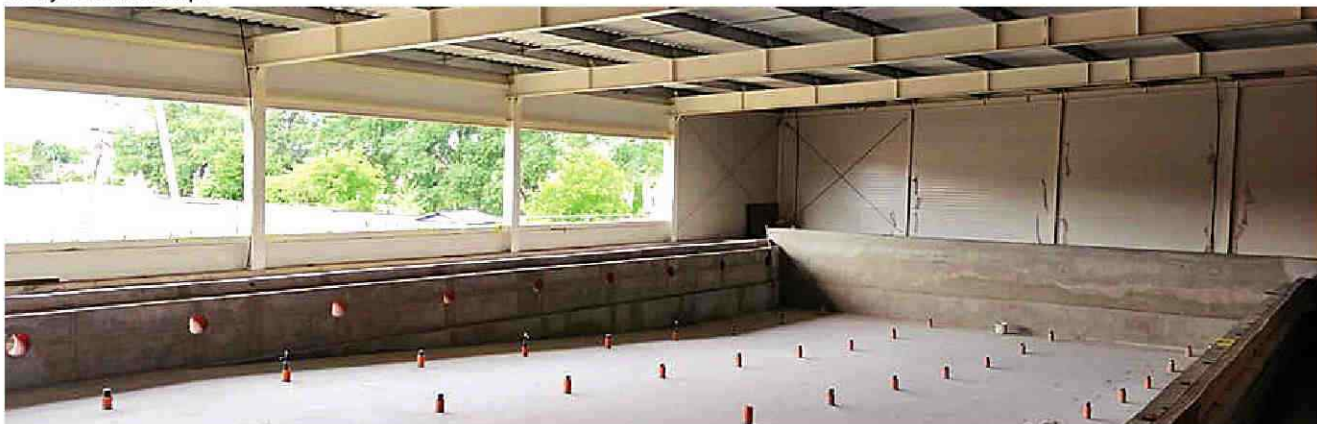
Wybetonowana główna niecka słupskiej pływalni
