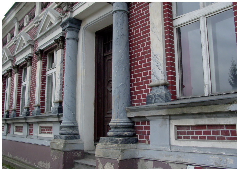
Zabytkowy dom Bronisława Gutowskiego - stan przed remontem (2004 rok)
